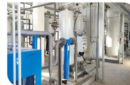
中石化宁波工程运行现场
